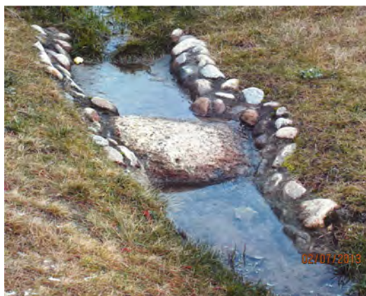
Sten i lavning for forsinkelse vaf vand
