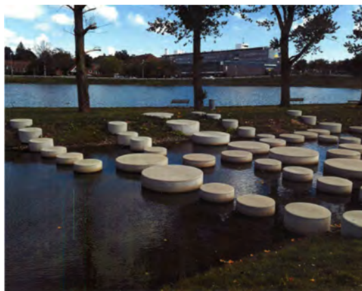
Betonplinter i vandrende
