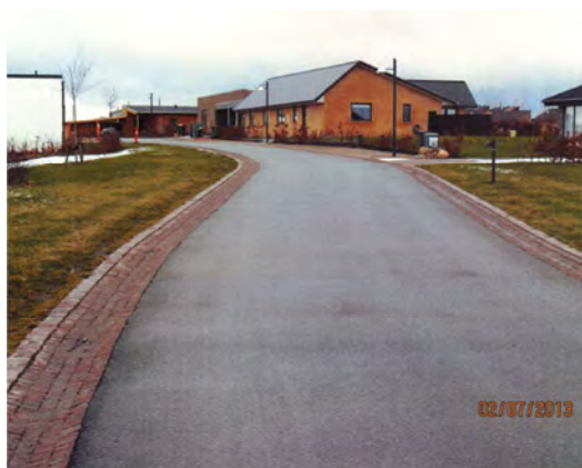
Render langs vej til styring af vand
