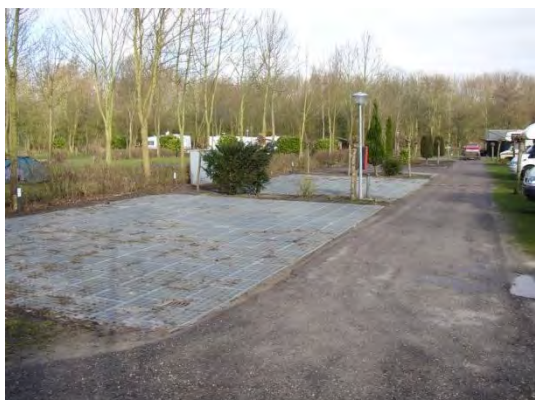
Permeable belægning på parkeringsplads
