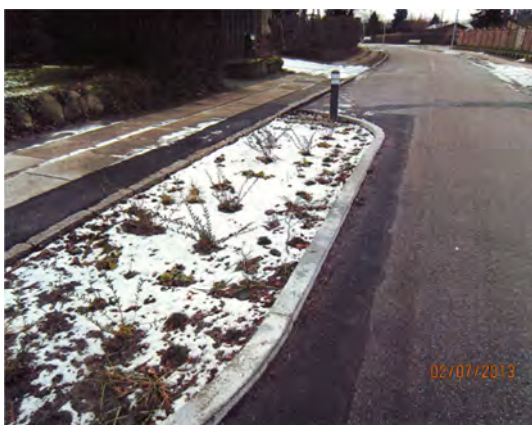
Vejbed til forsinkelse og rensning af vejvand
