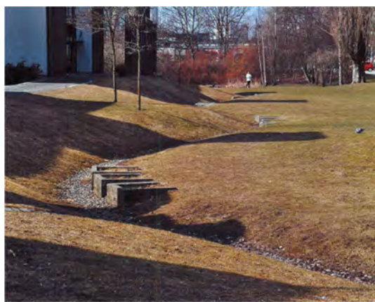
Lavning i park til ledning af vand
