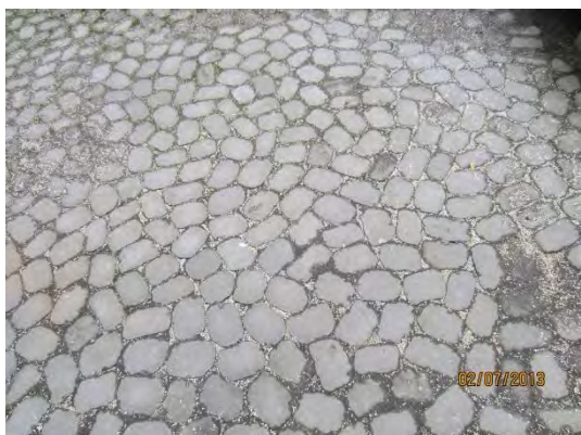
Permeabel belægning med sten
